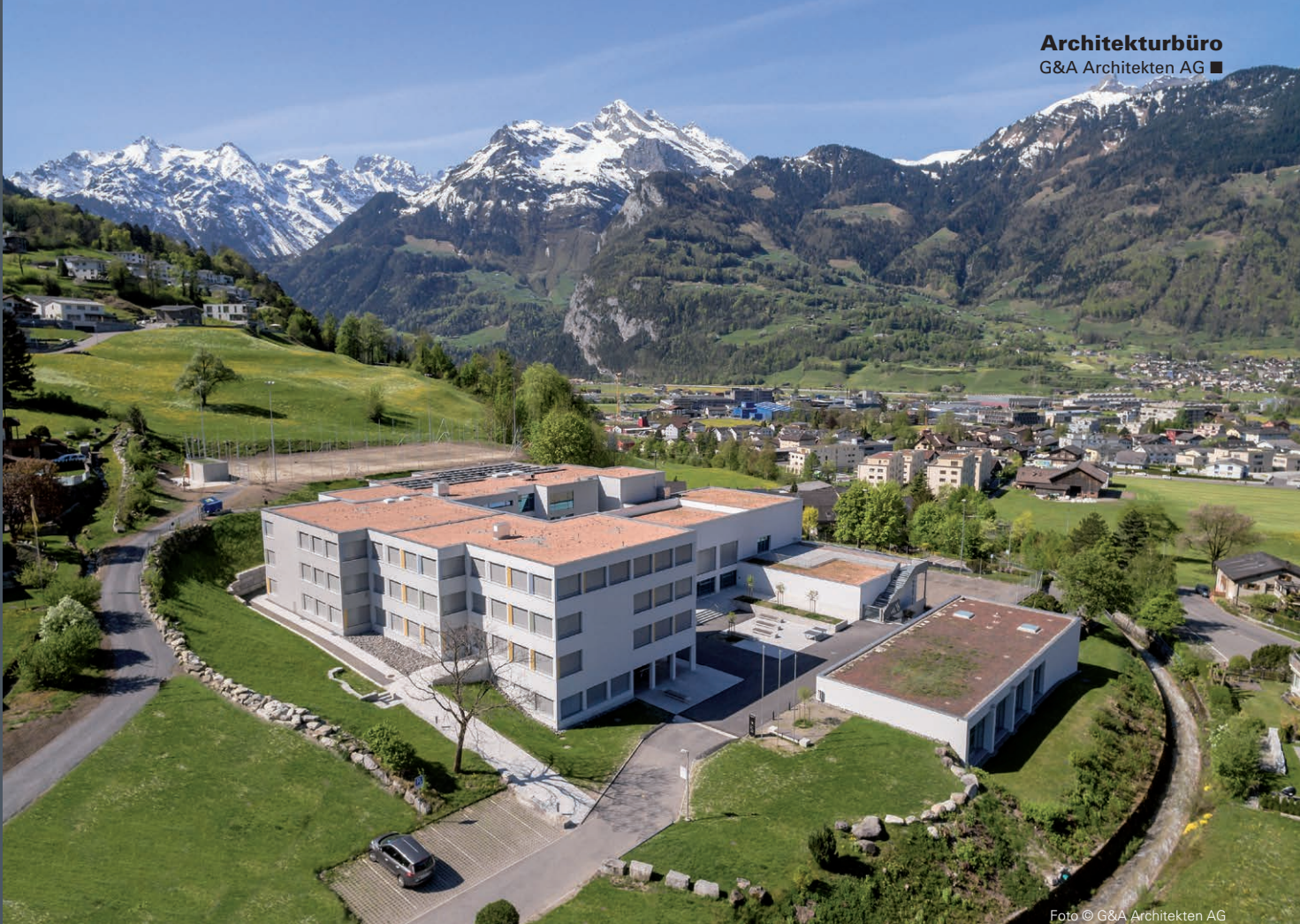
Foto © G&A Architekten AG
